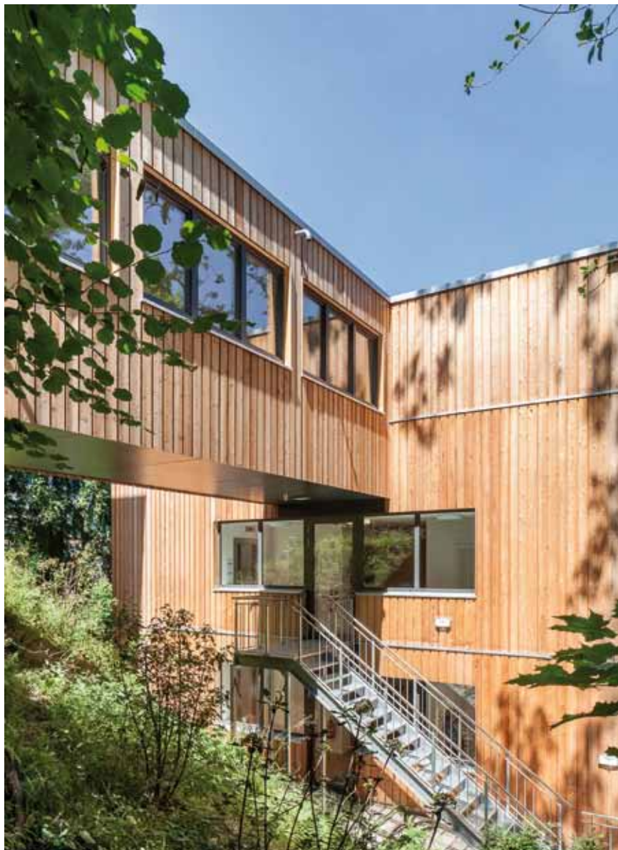
Die gute Tragfähigkeit von Holz wurde nicht zuletzt durch den freitragenden Verbindungssteg zwischen Neu- und Altbau der Klinik unter Beweis gestellt.
